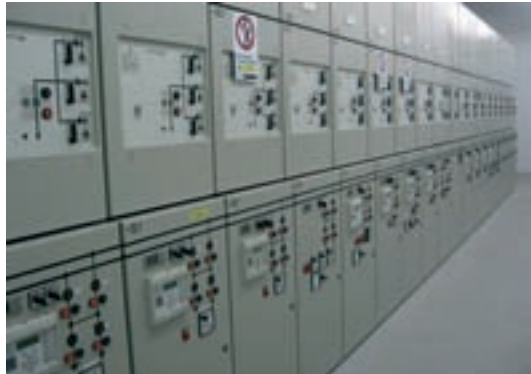
20 kV-SF 6 -Schaltanlage
