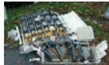
Umgefahrener Kabelverteiler
