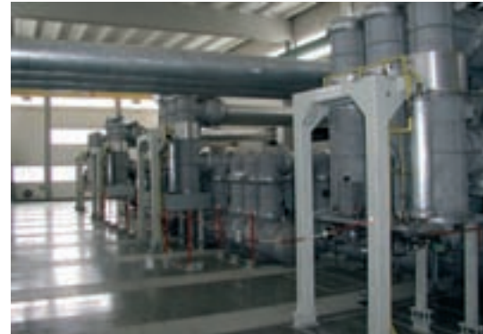
110 kV-SF 6 -Schaltanlage
