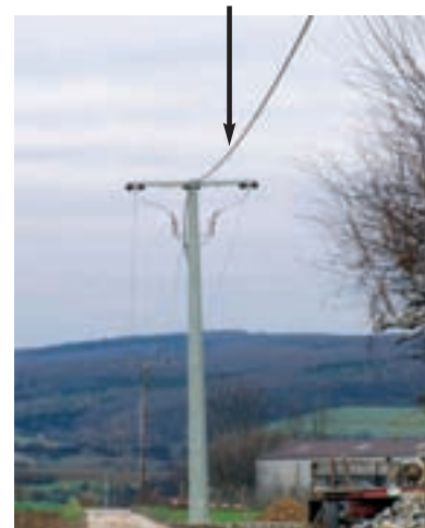
20 kV-Freileitung – isoliert
