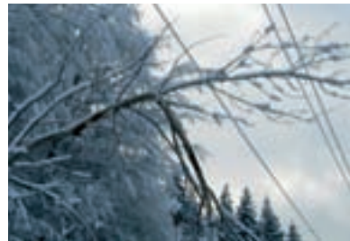
Äste in 110 kV-Freileitung
