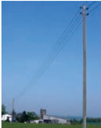
Masthöhe ca. 8 – 12 m Niederspannungsfreileitung
