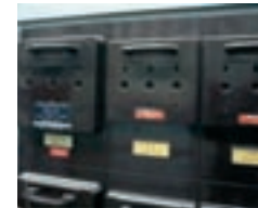
Lasttrennschalter mit NH-Sicherungen
