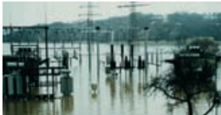
Überflutete Freiluftschaltanlage
