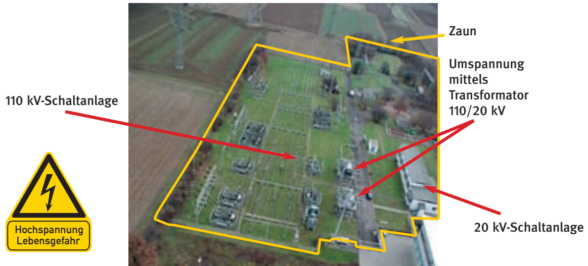
Luftbild einer Umspannanlage 110/20 kV
