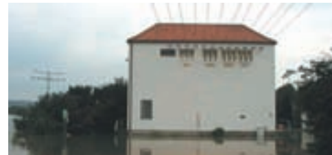
Überflutete Mittelspannungsschaltanlage
